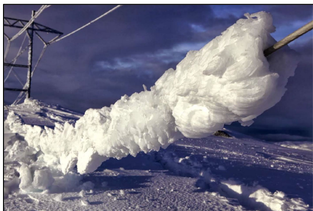
Fig. 1 - Icing on the broken OPGW shield wire
