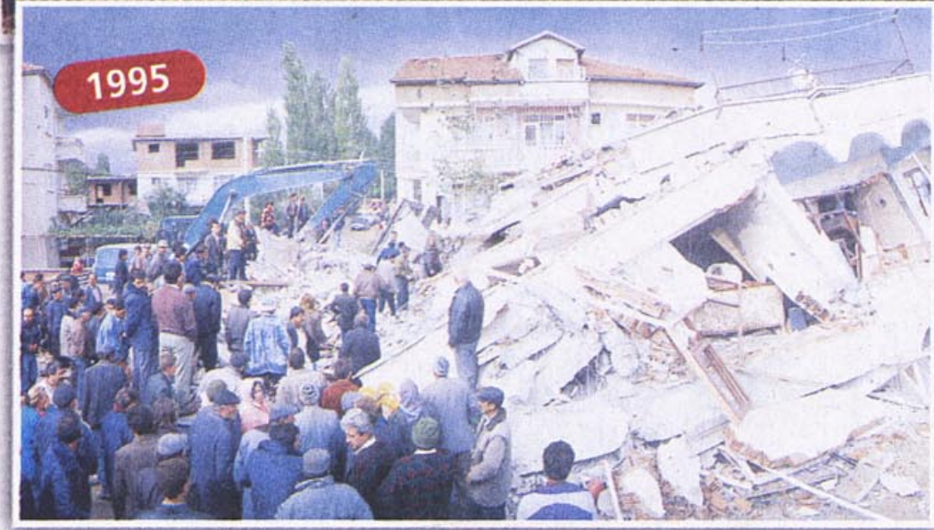
Yaklaşık 10 bin binanın hasar gördüğü Dinar'da depremden bir yıl sonra 3 bin 475 afetzedeye yeni konut yapılarak teslim edildi. İlçenin kanalizasyon, elektrik, telefon ve su şebekeleri de yenilendi.
